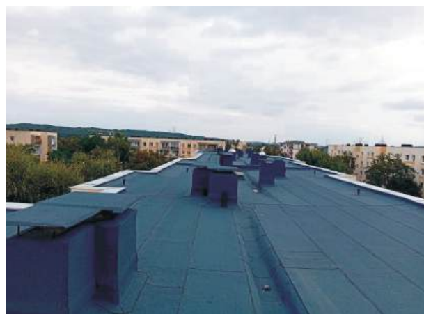
fot. wyremontowany dach budynku Pomorska 19
