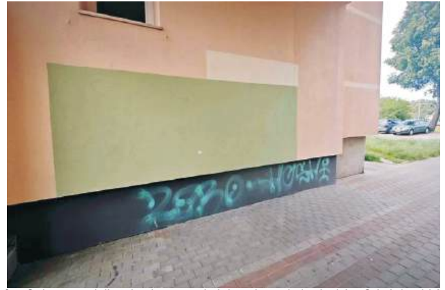
fot. Celem wandalii stała się po raz kolejny elewacja budynków Gdańska 4 i 6
