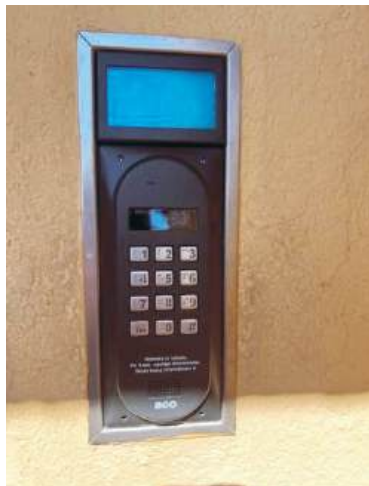
fot. nowy panel domofonowy
