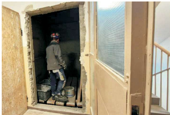
fot. wykuwanie otworów wejściowych do windy na każdym piętrze
