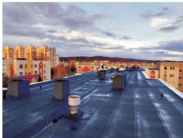
foto. Wyremontowany dach budynku Gdańska 47
