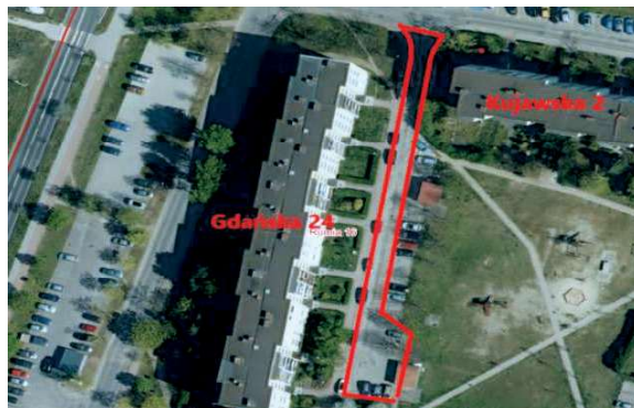
oraz wzdłuż budynku Gdańska 24
