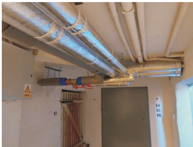
Fot. Zmodernizowana instalacja pozioma ciepłej i zimnej wody - Gdańska 31
