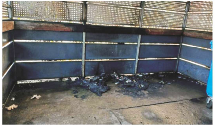
fot. zniszczona pergola przy ul. Pomorskiej 23
