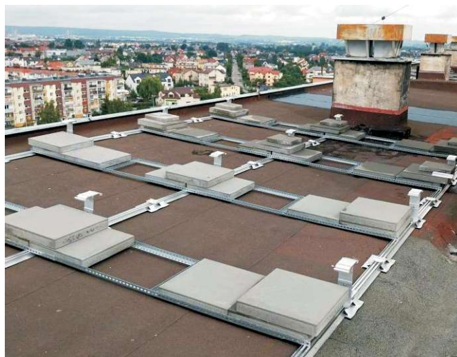
Fot. Przygotowania do montażu paneli na dachu
