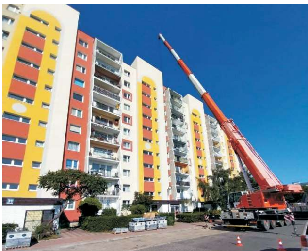
Fot. Instalacja paneli na dachu budynku przy ul. Wrocławskiej 31
