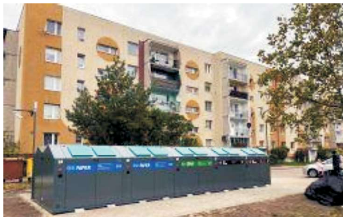
Fot. Montaż nowych pojemników przy ul. Poznańskiej 4
