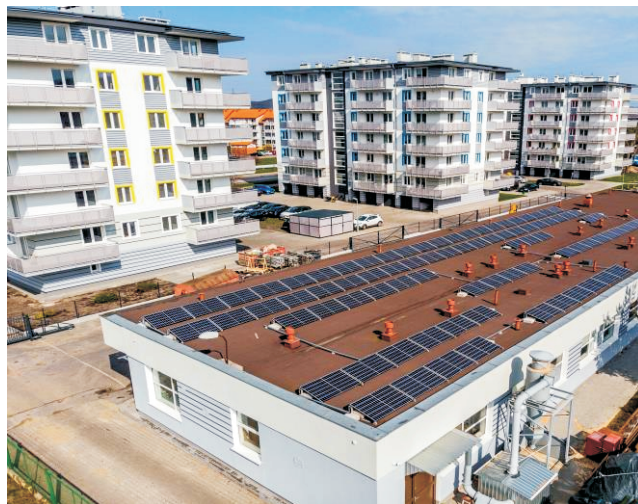
Panele fotowoltaiczne na dachu biura Spółdzielni
