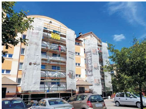
Na osiedlu Centrum trwa remont balkonów
