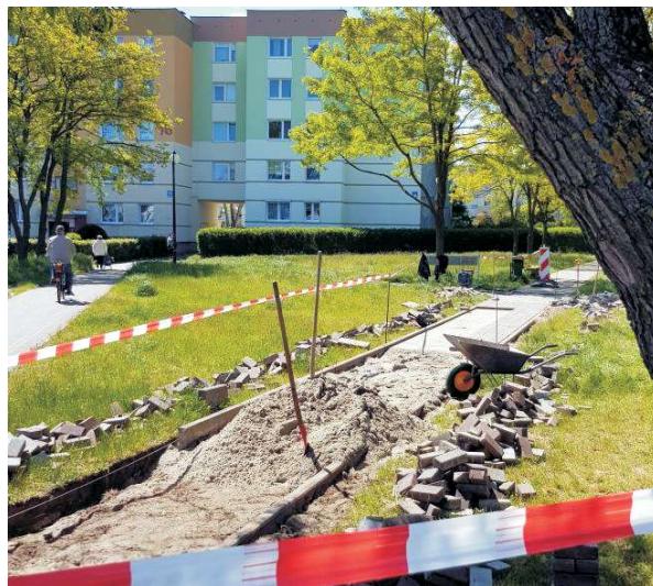
Trwają już prace wykończeniowe związane z remontem chodnika na ulicy Gdańskiej
