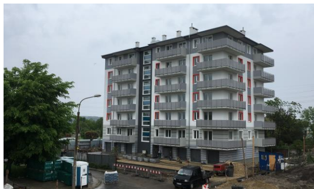
Prace związane z powstaniem pierwszego budynku przy ul. Dąbrowskiego 56 są już na ukończeniu
