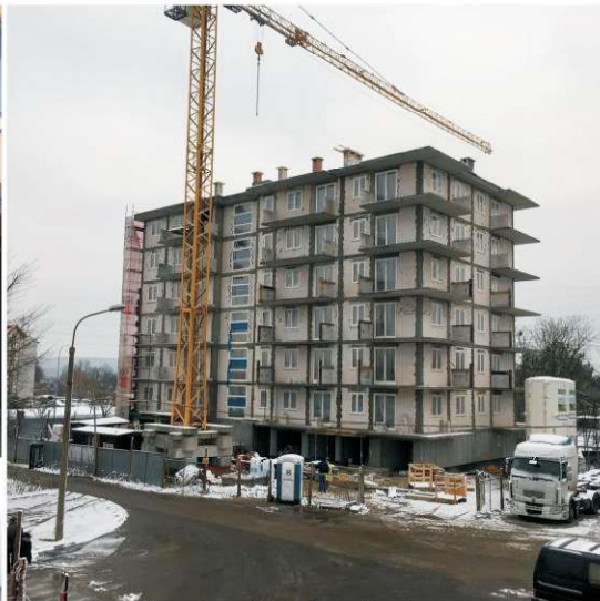
dwa budynki mieszkalne przy ul. Dąbrowskiego
