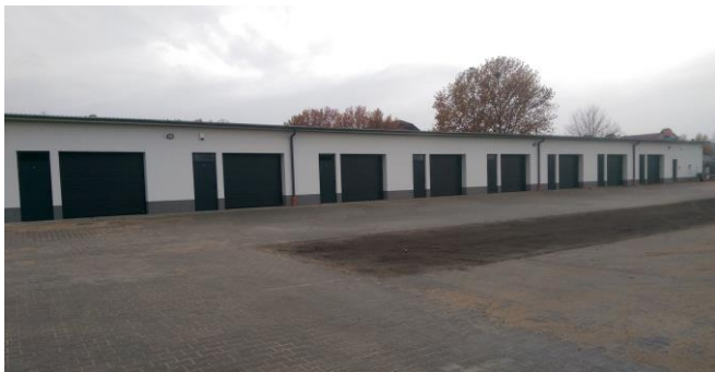
Niebawem z nowego budynku wielofunkcyjnego przy ul. Dąbrowskiego zaczną korzystać użytkownicy
