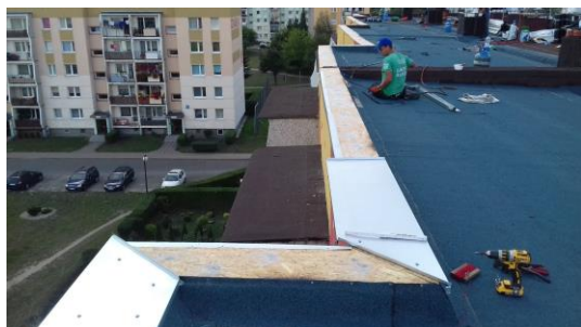
W trakcie remontu jest dach na bud. Gdańska 20
