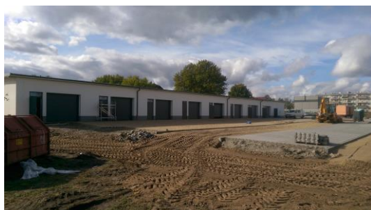
Na ukończeniu są prace związane z budową budynku wielofunkcyjnego przy ul. Dąbrowskiego
