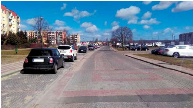
W ramach projektu nr 11 przewidziano m.in. remont nawierzchni ulicy serwisowej od Gdańskiej 33 do 41
