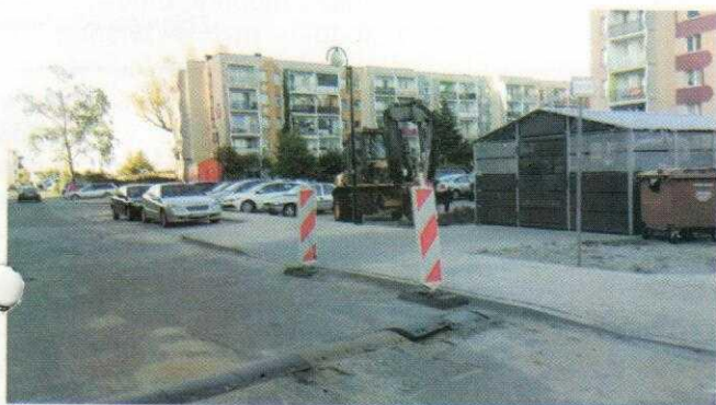
Na ukończeniu jest remont chodników w rejonie ul. Gdańskiej i Wrocławskiej
