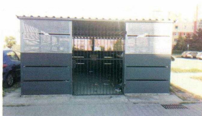
Zostały zmodernizowane kolejne pergole śmietnikowe
