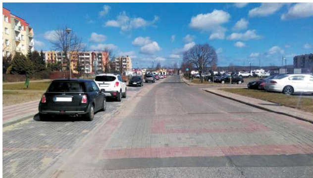
W ramach projektu przewidziano remont nawierzchni ulicy serwisowej od Gdańskiej 33 do 41
