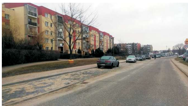
Wzdłuż ulicy Gdańskiej powstały już nowe miejsca postojowe...
