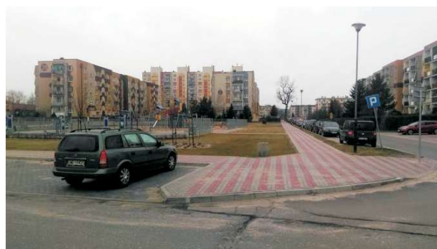
I wyremontowane zostały chodniki
