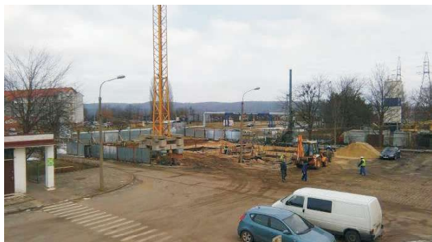
Przy ul. Dąbrowskiego powstaje budynek mieszkalny/
