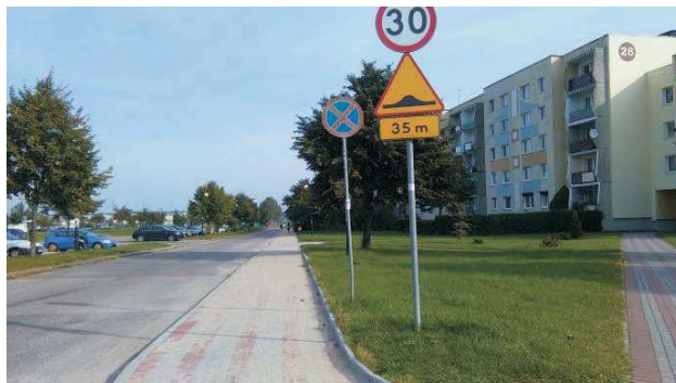
Zakończono już remont chodnika przy ul. Gdańskiej
