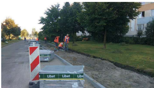
Trwa remont chodnika przy ul. Gdańskiej
