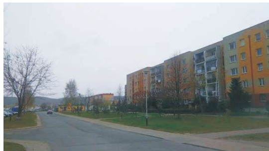
W ramach projektu przewidziano wymianę opraw lamp m.in. wzdłuż budynków Gdańska 33 i 41
