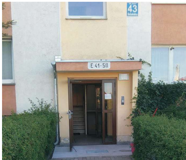
Wykonano remont podestów przed wejściami do kolejnych budynków
