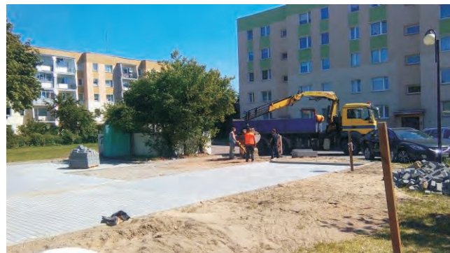
Nowy parking powstaje też przy Gdańskiej 20
