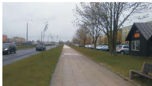
Drugi projekt zakłada remont chodnika i budowę ścieżki rowerowej wzdłuż ul. Gdańskiej (na odcinku od ul. Katowickiej do Pomorskiej)
