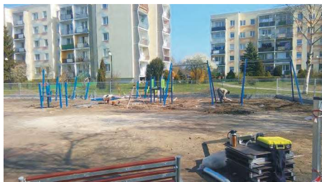
Rozpoczął się już montaż urządzeń zabawowych
