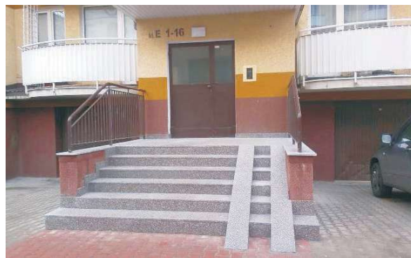
Wyremontowane zostaną podejścia przed wejściami do kolejnych budynków
