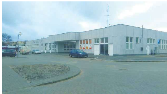
Zakończyła się już rewitalizacja pawilonu przy ul. Pomorskiej 11
