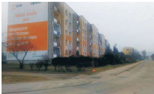
W tym roku zostanie wyremontowany m.in. chodnik wzdłuż bud. Gdańska 28
