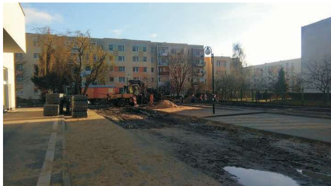
Na ukończeniu jest budowa drogi wokół pawilonu
