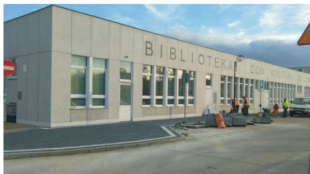
Od zewnętrznej strony pawilonu trwają prace brukarskie
