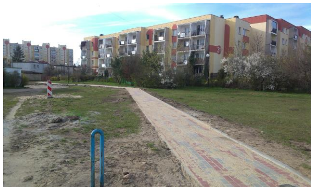
Zbudowano chodnik od bud. Gdańska 31 d w kierunku ul. Katowickiej
