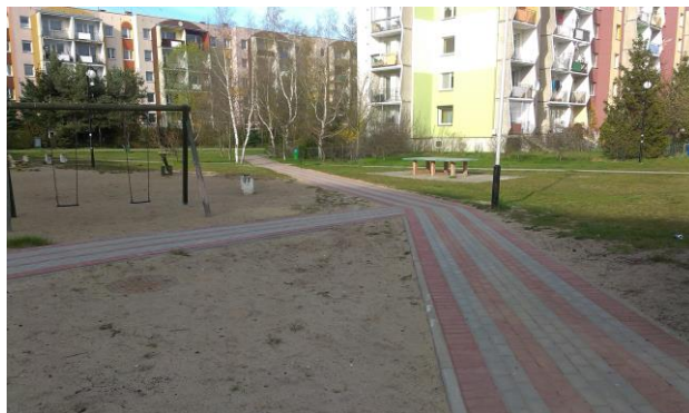
Wyremontowano też chodnik od łącznika Gdańska 26 w kierunku ul. Pomorskiej
