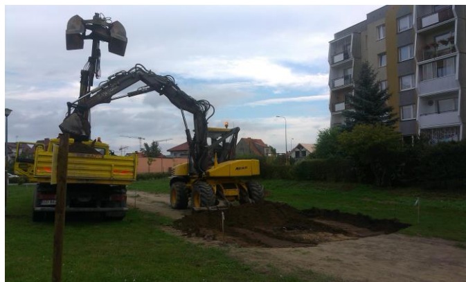
Na terenie budowy możemy zobaczyć już specjalistyczny sprzęt
