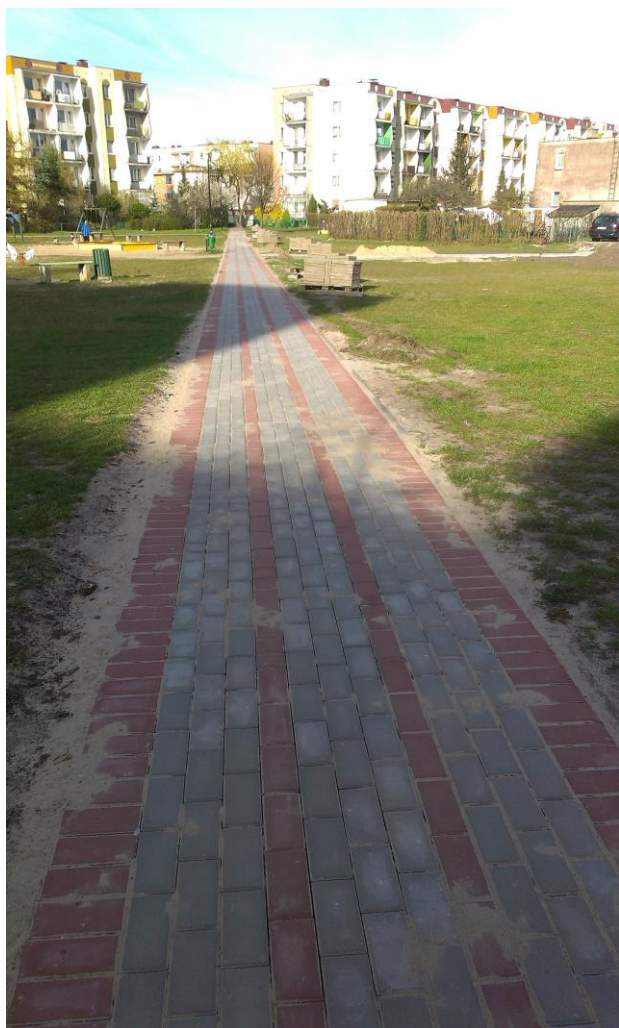
Chodniki w rejonie budynków Gdańska 22 i 24
