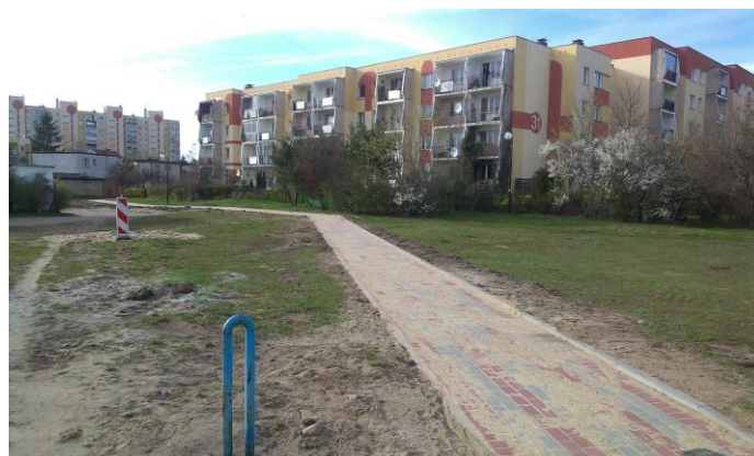
Powstał już chodnik od budynku Gdańska 31 w kierunku ul. Katowickiej
