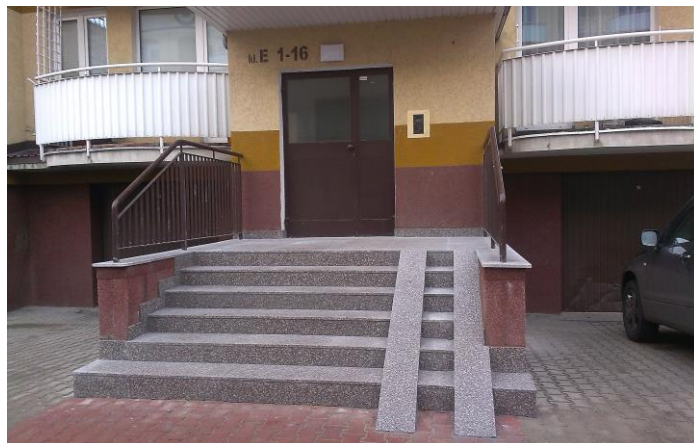
W ubiegłym roku wyremontowane zostały podesty m.in. w budynku Opolska 5
