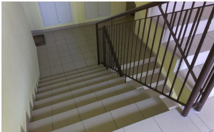
Od tego roku w trakcie malowania klatek będą również układane na schodach płytki terakotowe
