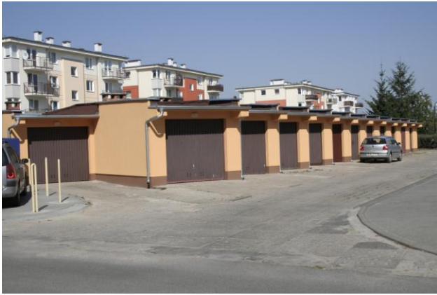
Odnowiona elewacja na garażach przy ul. Wrocławskiej
