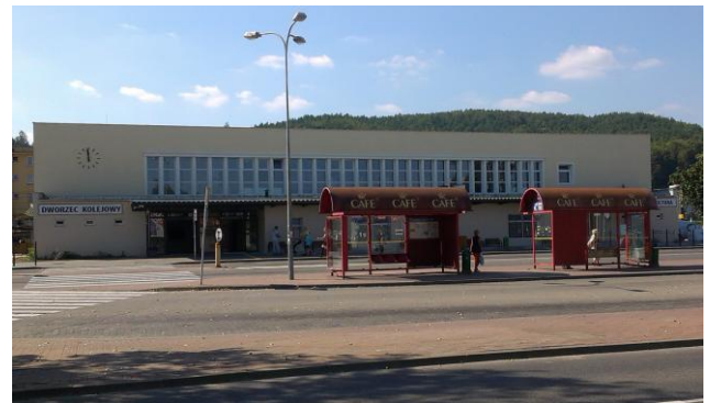
Budynek dworca jest już wyremontowany
