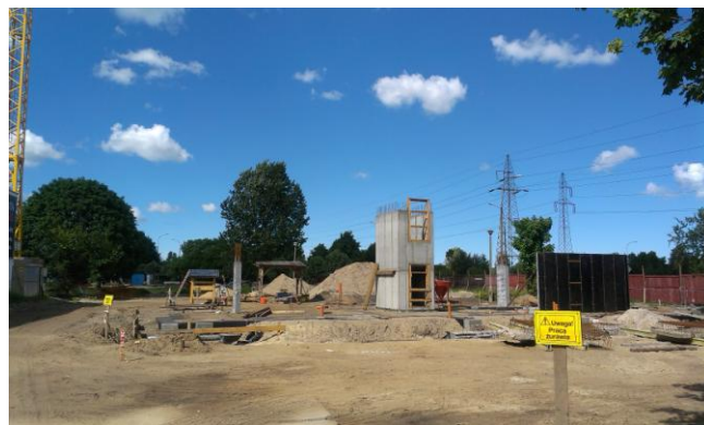
Gotowe są fundamenty nowego budynku przy ul. Pomorskiej
