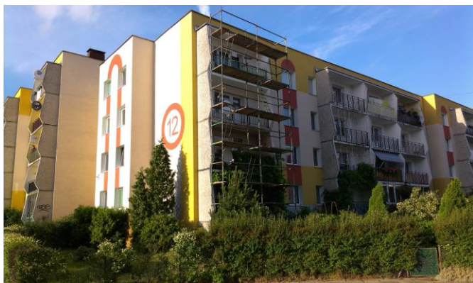
Trwają remonty opierzeń balkonów
