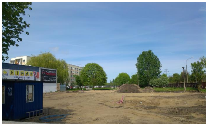
Teren wokół budowy został już ogrodzony, przygotowany i niebawem rusza praca
