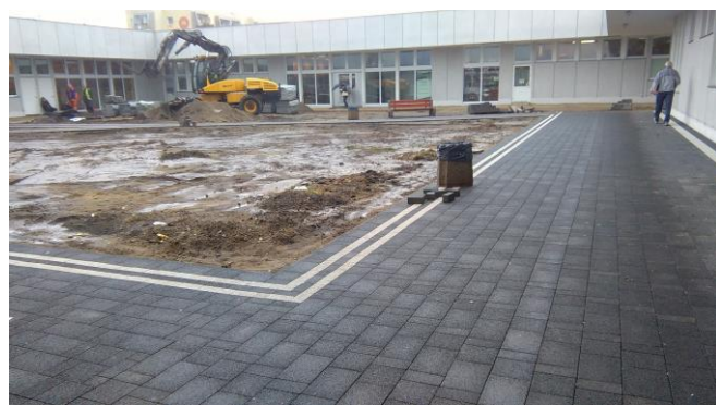
Na wewnętrznym patio trwają prace brukarskie, lada dzień rozpoczyna się też nasadzenia
