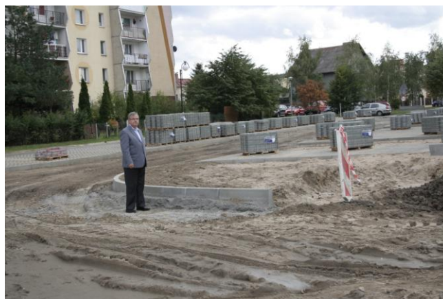
Prezes Spółdzielni, Józef Chmielewski, na bieżąco monitoruje prace związane z budową drogi
